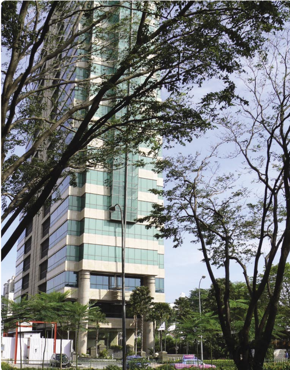
De Goldbell Towers zijn perfect benoemd: ze hebben een gouden glans. De kantoren van de Singapore Exhibitions Company zijn hier op de elfde verdieping gevestigd.
