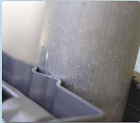
Markering voor het afstellen van de motor op de mast op het zuiden
