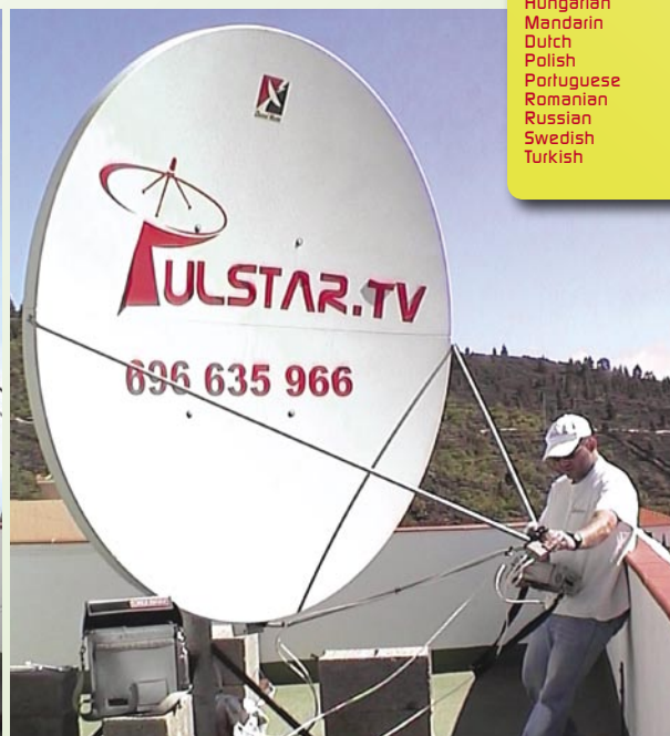
■ De kleine elevatie die nodig is voor de ontvangst van Amerikaanse satellieten valt gelijk op. Aangezien Diego's locatie hoog in de bergen is, is hij in staat nog ontvangst te houden zelfs bij een dergelijke kleine elevatie.
