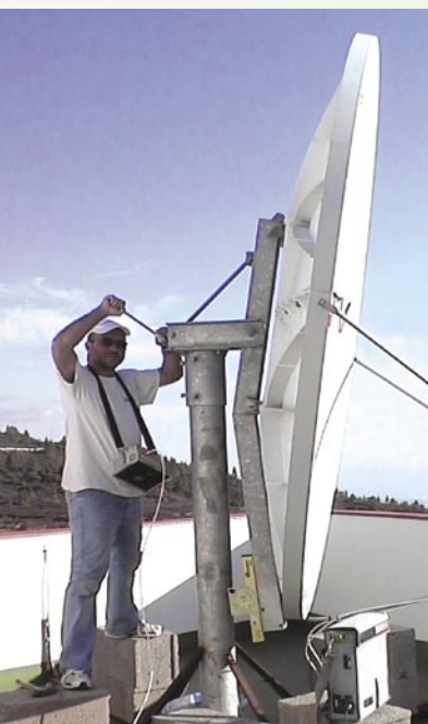
■ De kleine elevatie die nodig is voor de ontvangst van Amerikaanse satellieten valt gelijk op. Aangezien Diego's locatie hoog in de bergen is, is hij in staat nog ontvangst te houden zelfs bij een dergelijke kleine elevatie.
