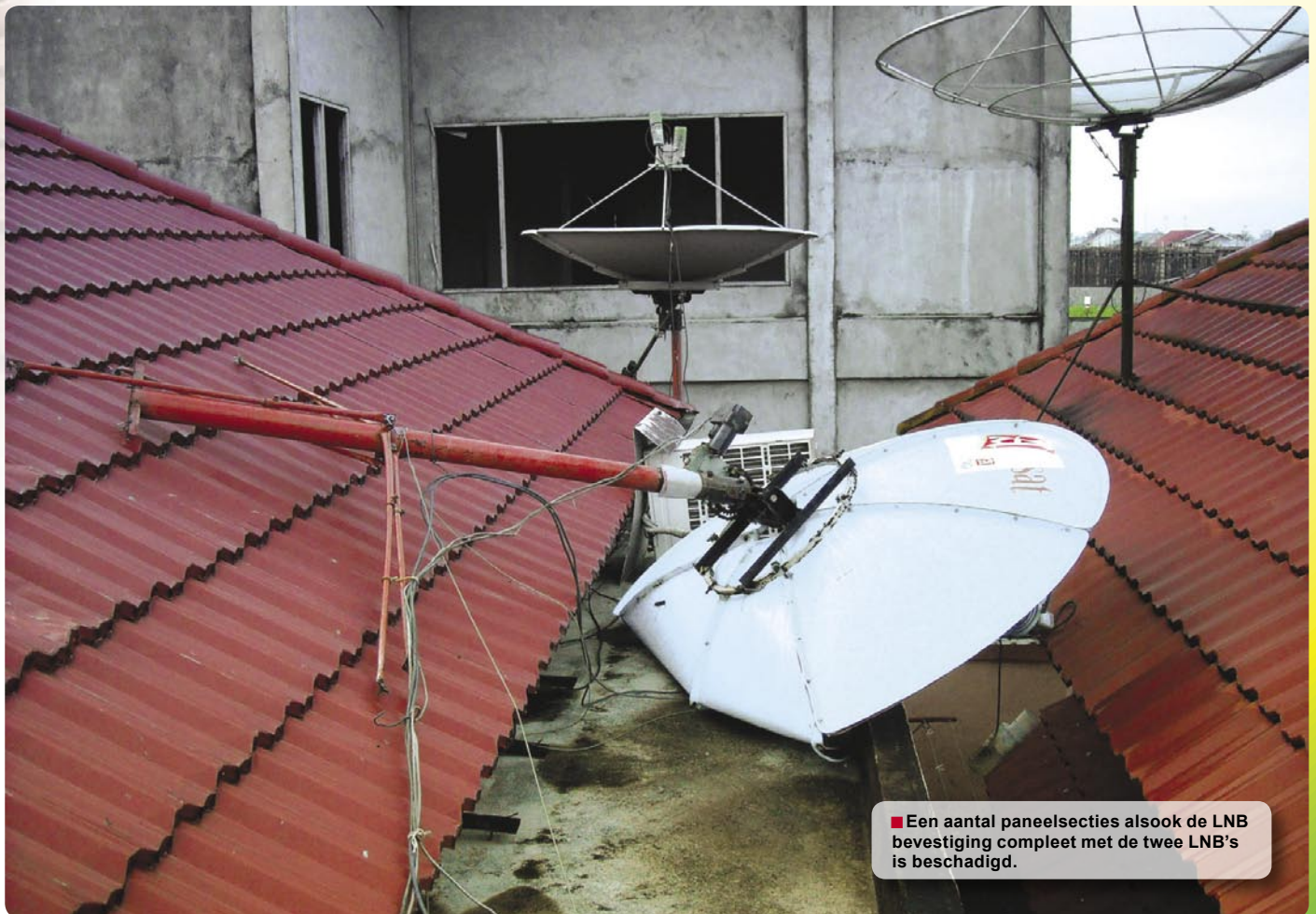
■ Nu: Watzonde – de 1,8m schotel is ingestort als gevolg van zijn hoge windbelasting.
