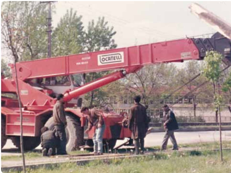
■ De kraan wordt voorbereid
