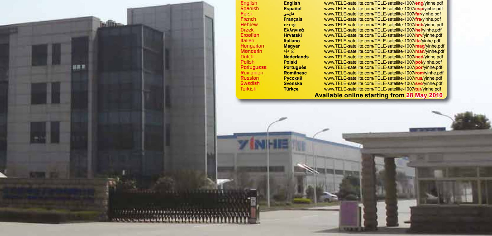
■ YINHE's hoofdingang. Het administratiegebouw bevindt zich links achter wat een enorm aantal bedrijfshallen blijkt. Hier werken 1500 werknemers.
